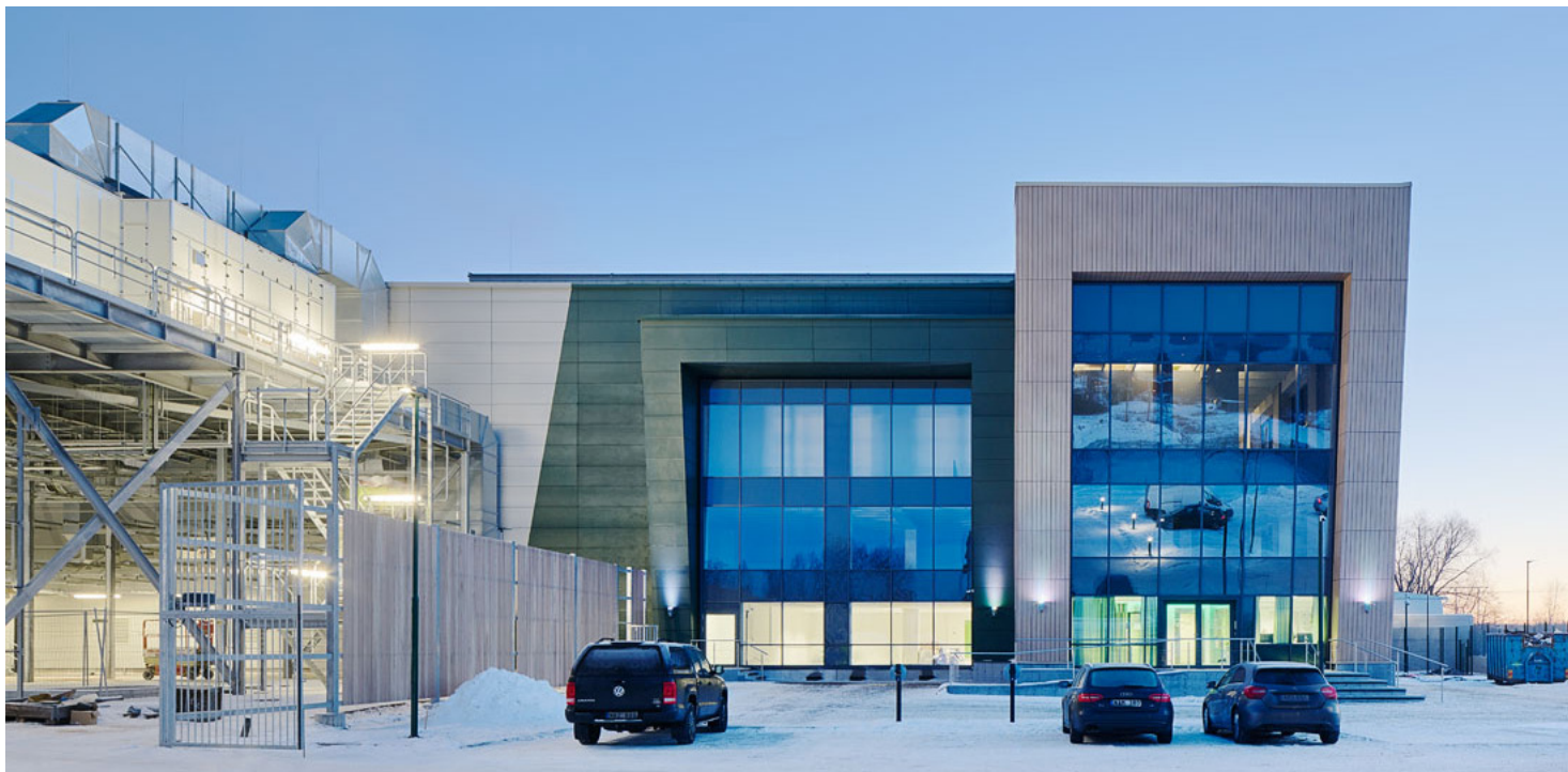
Digiplex datacenter i Upplands Väsby.
